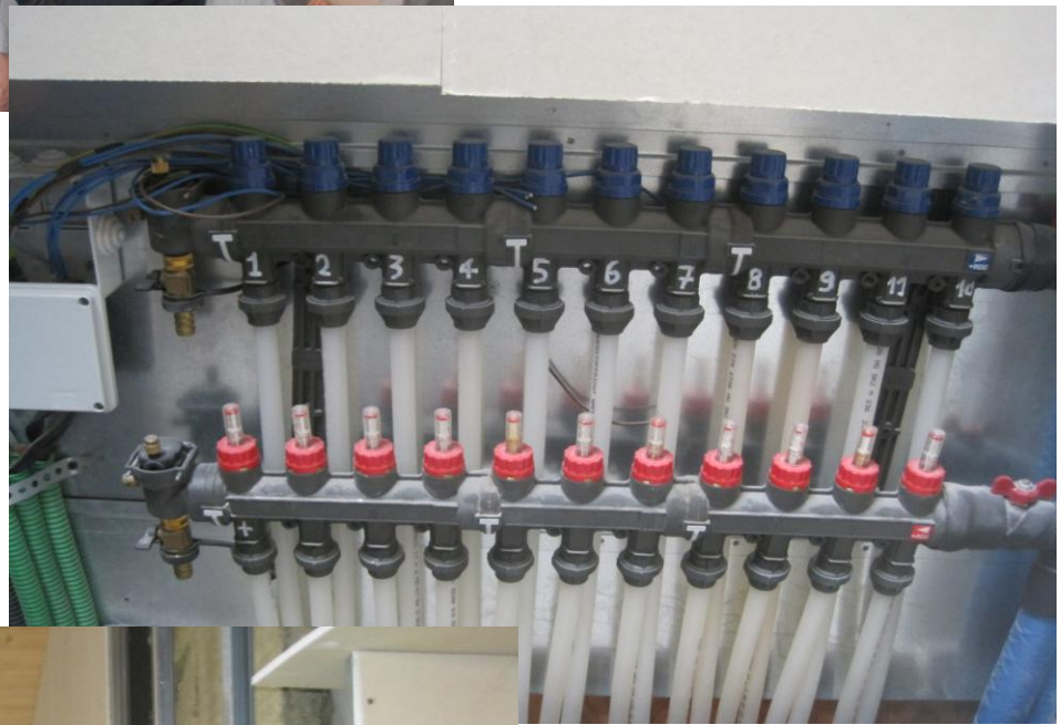
Dettaglio collettore di appartamento per il riscaldamento/raffrescamento a pavimento, realizzato con pompe di calore azionate dall'energia dei pannelli solari.
