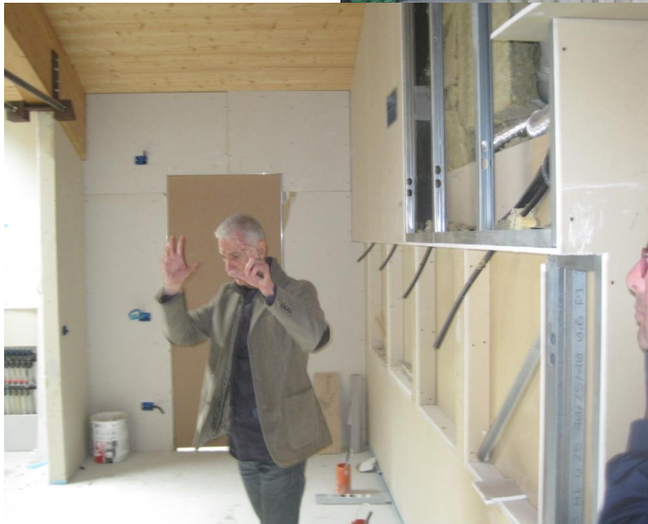
Sottotetto: materiali di costruzione e isolamento acustico e termico
